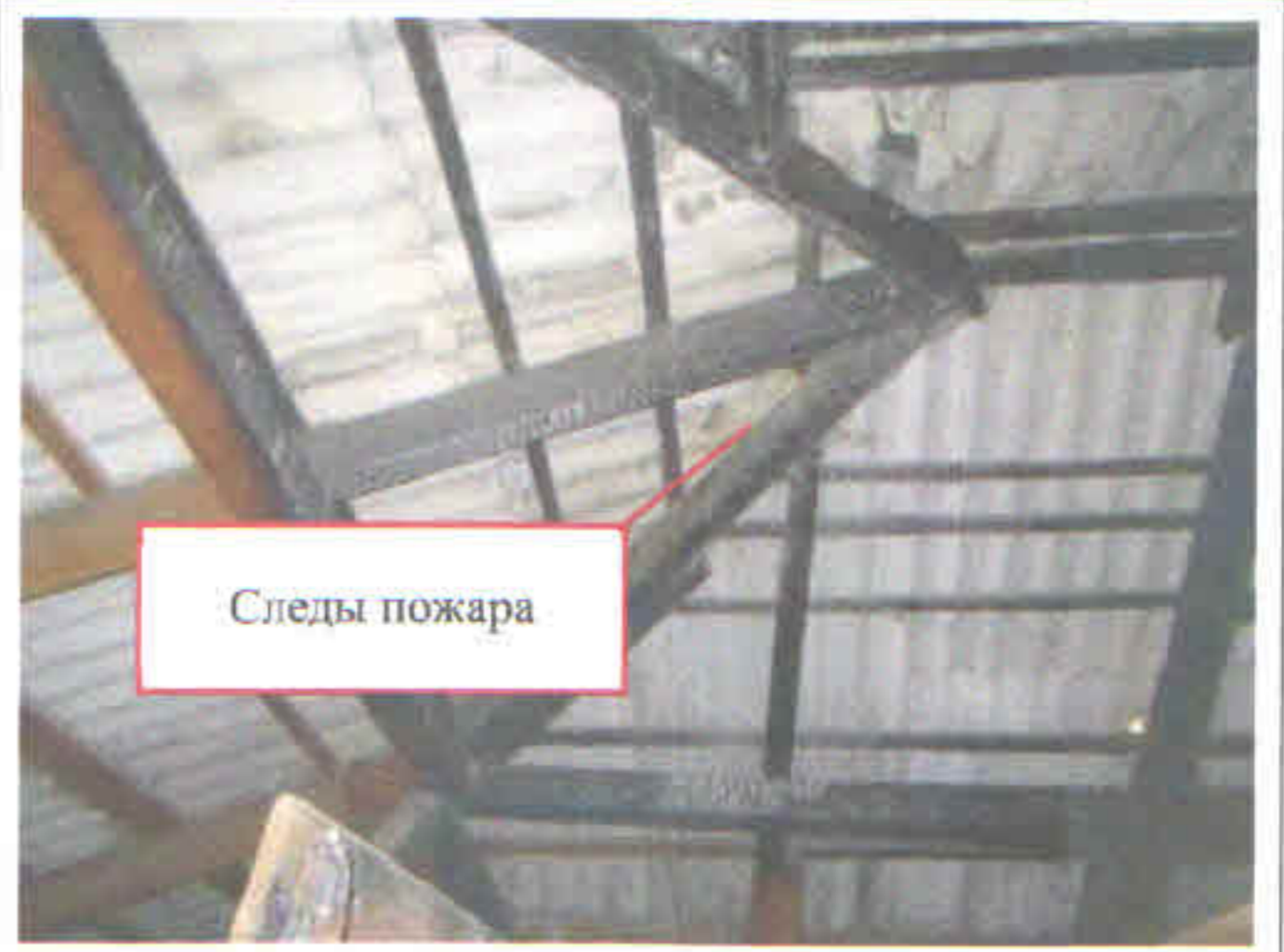
Фото 14 – Фрагмент крыши в осях 1-4/А-В
