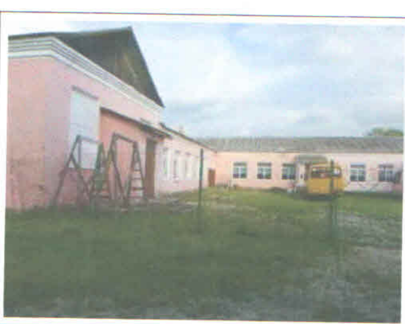
Фото 2 – Общий вид здания в осях 5-4/Е-В
