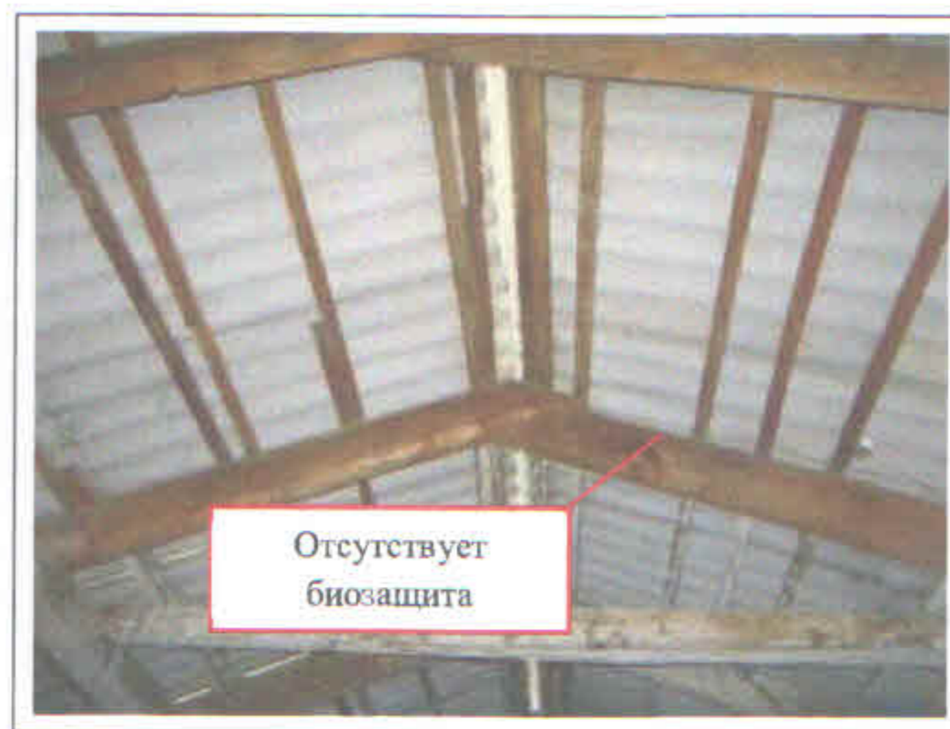
Фото 15 – Общий вид конструкций крыши
