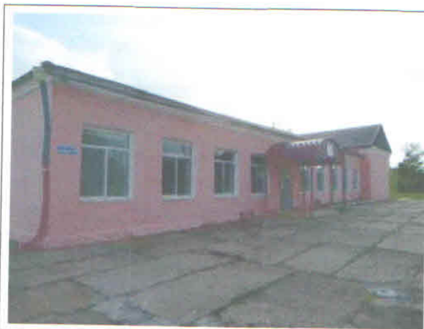
Фото 1 – Общий вид здания по оси 10 м/о А-Е
