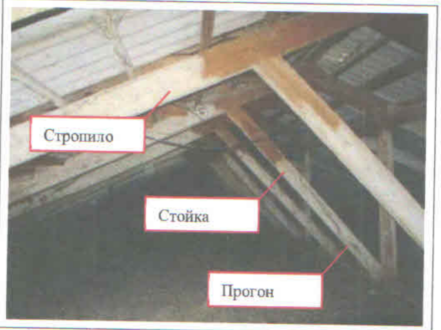
Фото 11 – Общий вид крыши в осях В-А/4-5
