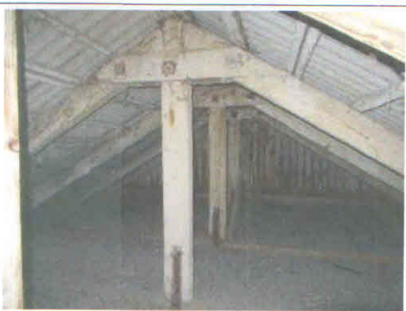
Фото 5 – Общий вид перекрытия в осях 6-9/Ж-Е
