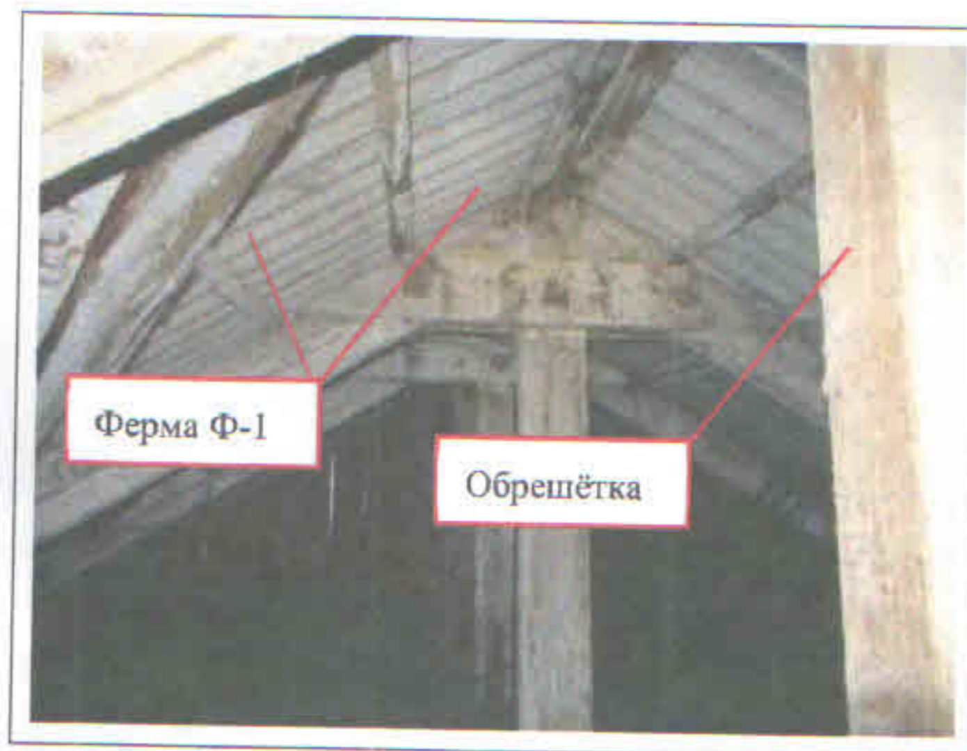
Фото 12 – Общий вид крыши в осях Е-Г/5-6
