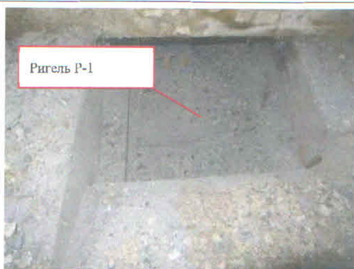
Фото 4 – Общий вид узла опирания балок на Ригели
