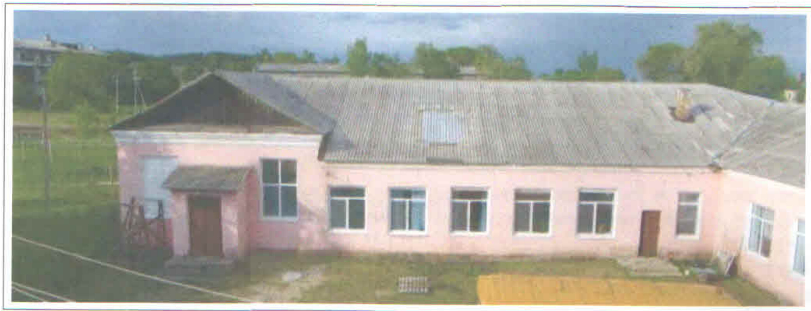
Фото 9 – Общий вид крыши в осях 4-5/Е-А
