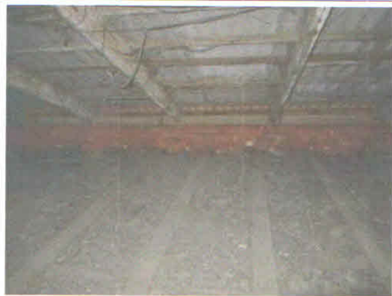
Фото 3 – Общий вид перекрытия в осях 1-2/Г-Д
