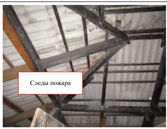
Фото 14 – Фрагмент крыши в осях 1-4/А-В
