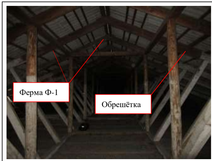
Фото 10 – Общий вид крыши в осях 1-4/В-Г
