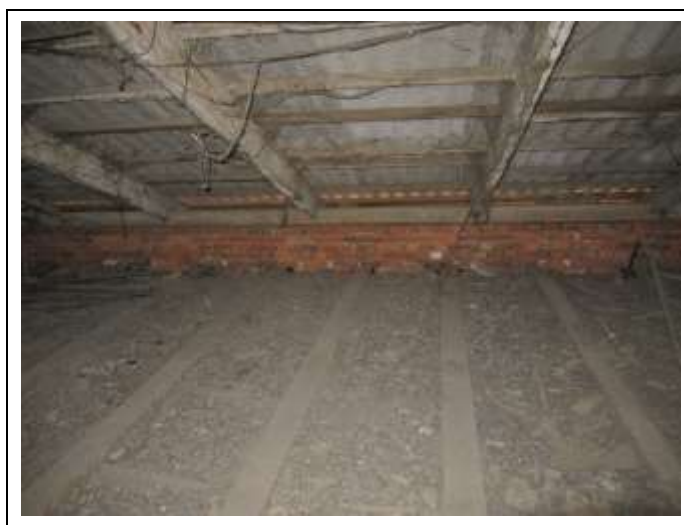
Фото 3 – Общий вид перекрытия в осях 1-2/Г-Д
