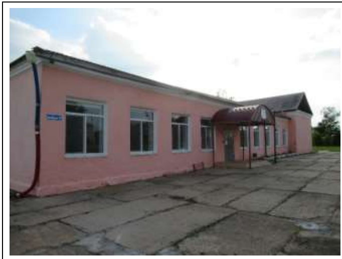
Фото 1 – Общий вид здания по оси 10 м/о А-Е
