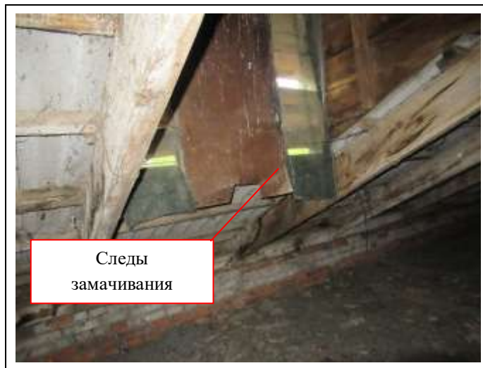
Фото 13 – Общий вид слухового окна
