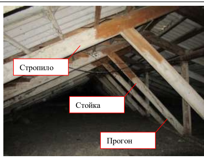
Фото 11 – Общий вид крыши в осях В-А/4-5
