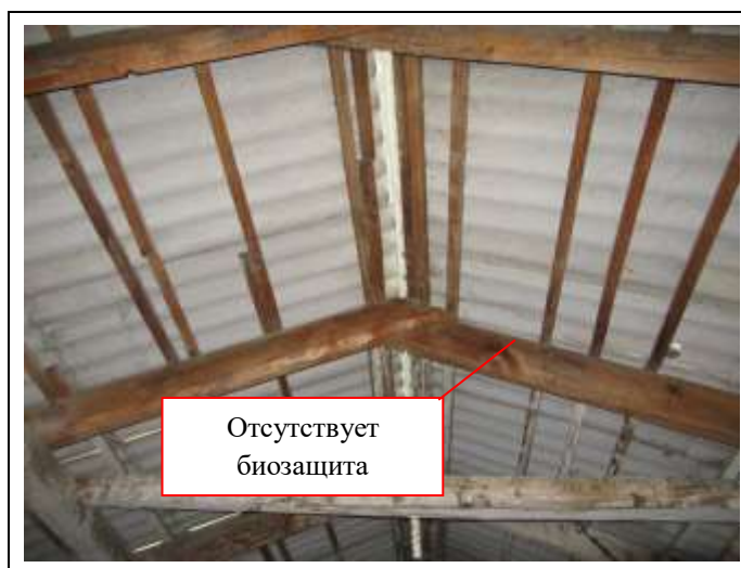
Фото 15 – Общий вид конструкций крыши
