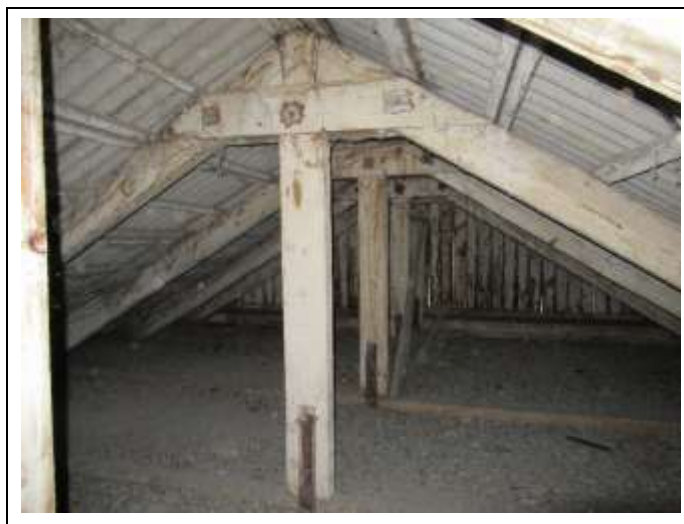
Фото 5 – Общий вид перекрытия в осях 6-9/Ж-Е
