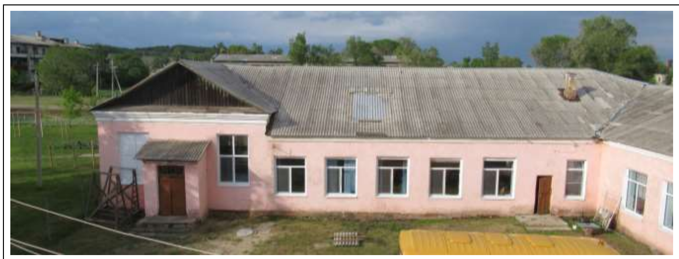
Фото 9 – Общий вид крыши в осях 4-5/Е-А
